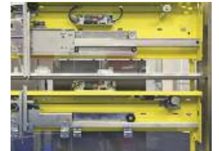
Türantrieb im Standby stromlos
